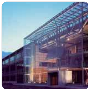
RENEWABLE ENERGIES CENTRE località Sazza San Maurizio d'Opaglio (NO)
