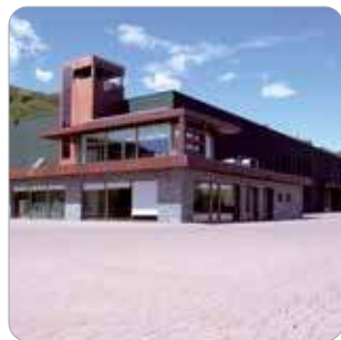
NEW PRODUCTION UNIT San Maurizio d'Opaglio (NO)
